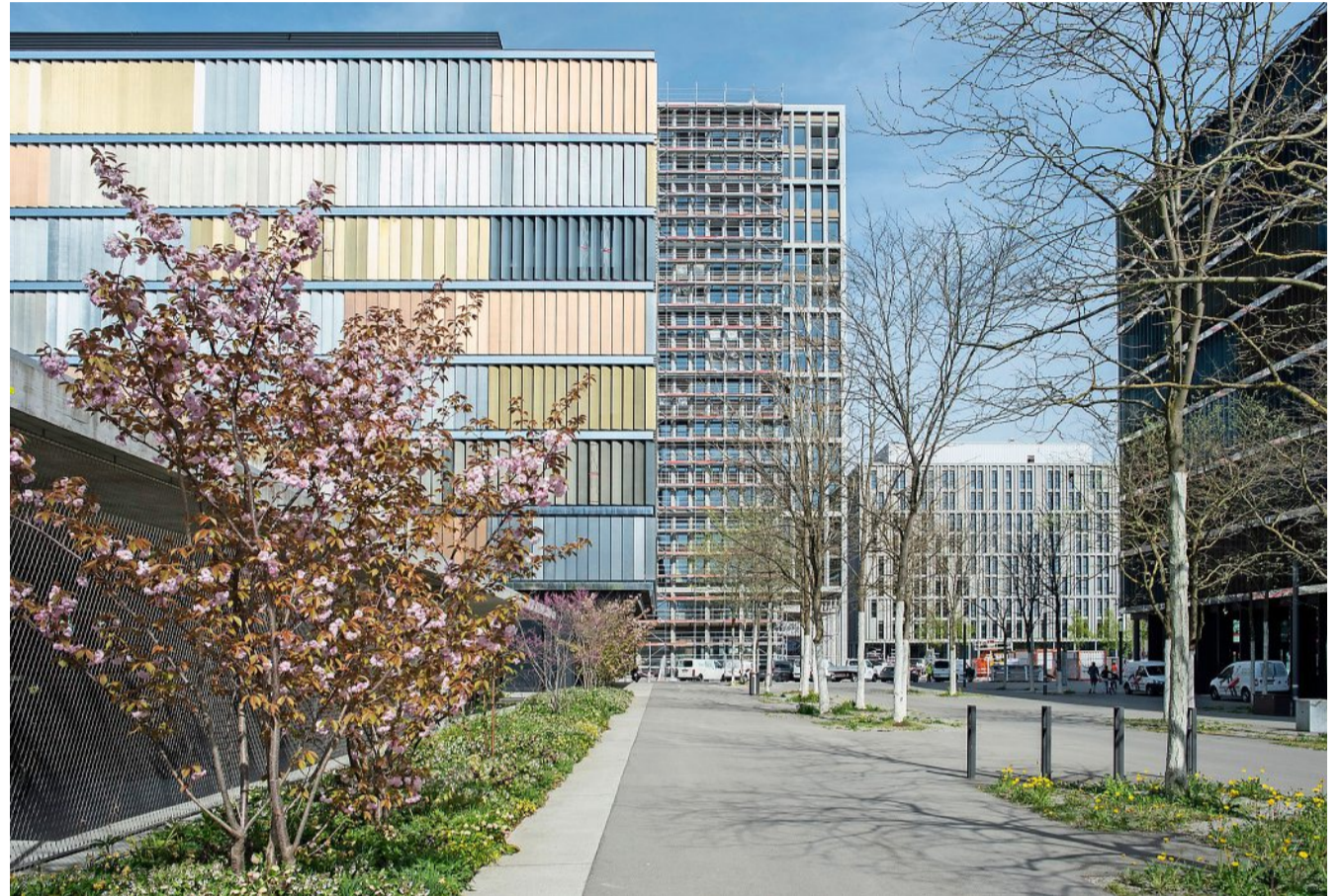
Die Monotonie der Fassaden und Strassen in der Wankdorf-City lädt kaum zum Verweilen ein. Foto: Franziska Rothenbühler
