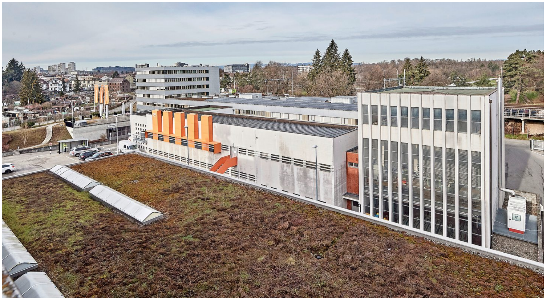
Hinter dem Gebäude rechts soll das EWB-Hochhaus entstehen. Mit 110 Metern wäre es das höchste Gebäude in der Stadt Bern. Foto: Adrian Moser
